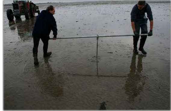
Mise en place d'ancres à vis sur fond de vase et sable
