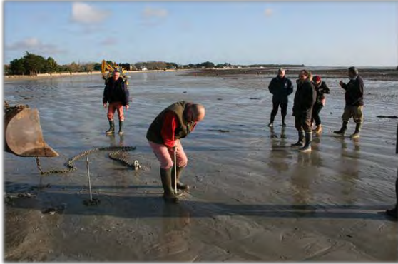
Installation d'ancres à vis pour essais
